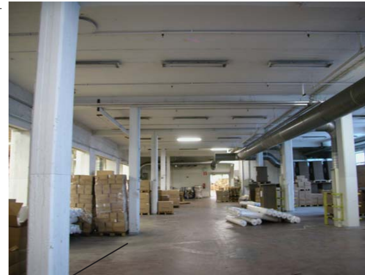
Betonipilari ja alalaatta.
