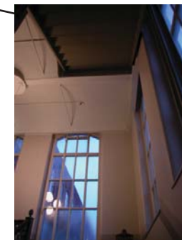
Leikattu kappaholvi portaan jatkoa varten.
