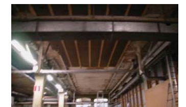
Keskiosassa on erilaisia rakenteita eri ajoilta. Vanha kappaholvi uudet betonirakenteet.
