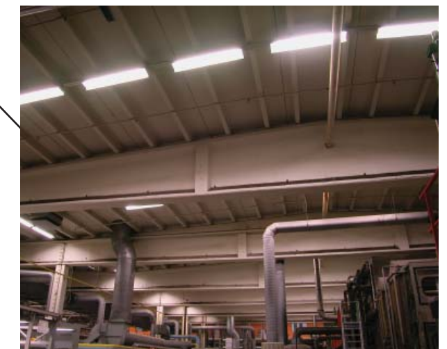
Vuonna 1970 sijoitettiin vierekkäin kaksi harjapalkkia tilan keskellä betonipilarilinja. Rakennusta voi muokata vapaasti.
