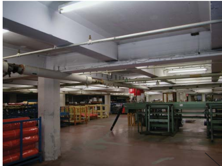
Vuoden 1960 jälkeen umpeen rakennetun sisäpihan rakenteet erottuvat muun tilan rakenteista.
