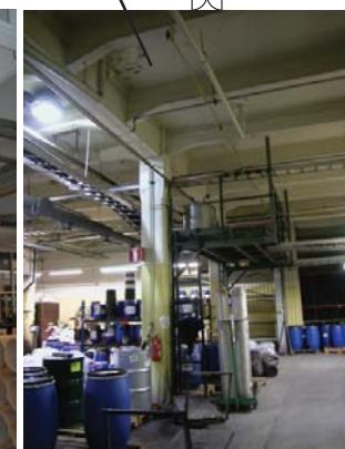
Uudet rakenteet: Hennebique järjestelmä
