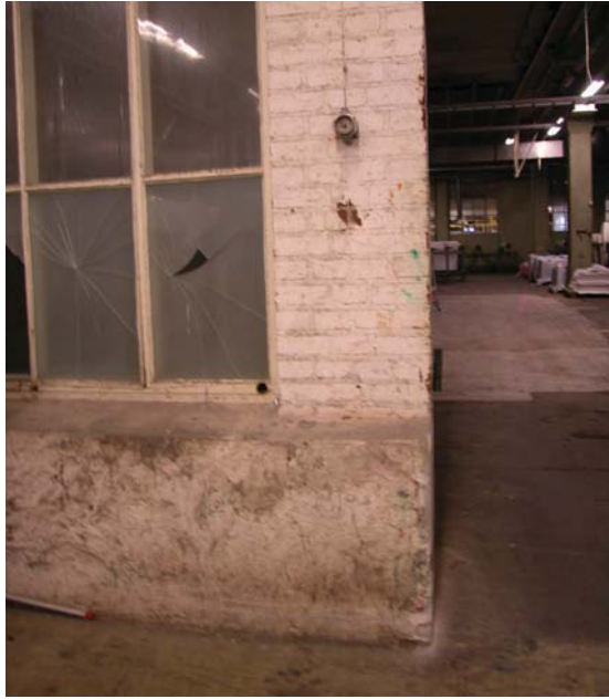
Vanha 1896 ulkoseinä näkyy rakennuksen sisällä.
